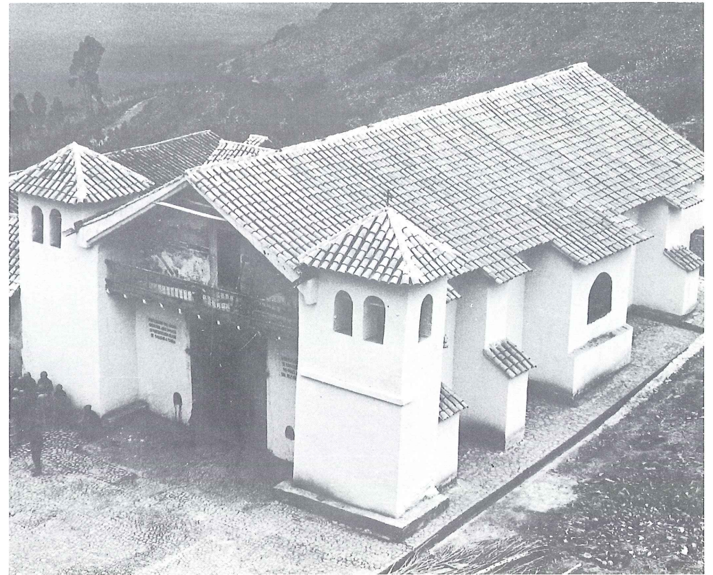
Después de los trabajos de restauración. After restoration
