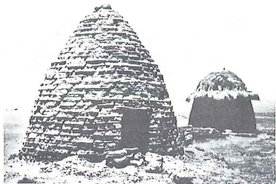
CHAMPA, panes de hierba o sod: apilamiento de porciones de suelo con hierba. SOD: clods of soil piled with grass.
